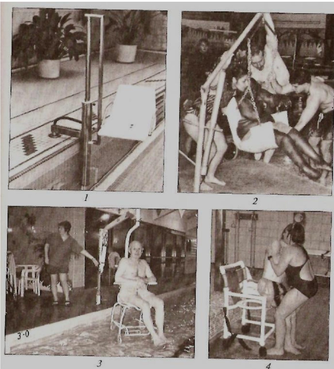
Мал. 2. Спеціальні крісла-підйомники на кронштейнах (1-3) і спеціальне крісло для переміщення в басейні (4).
